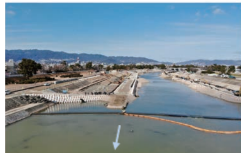
武庫川 河道対策 (尼崎市、西宮市)
