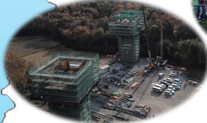
東播磨道 室山高架橋(小野市)
