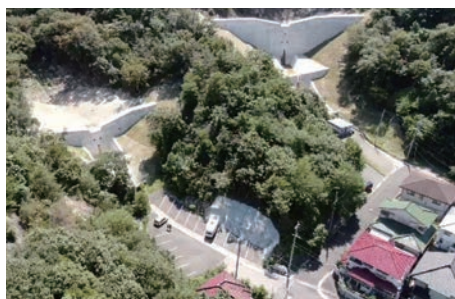
旭6川、旭7川 砂防堰堤（相生市）
