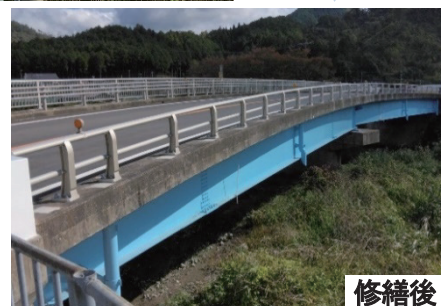
県道 物部藪崎線 新馬背場橋 橋梁修繕 (朝来市)
