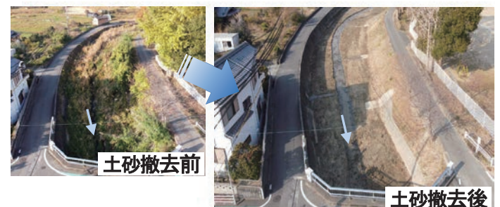
生穂川 堆積土砂撤去 (淡路市)
