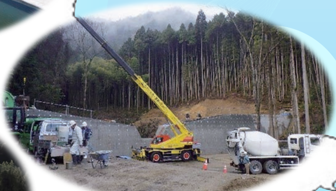
岩崎川砂防堰堤整備(丹波篠山市)
