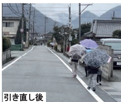
道路区画線の引き直し (西脇市)
