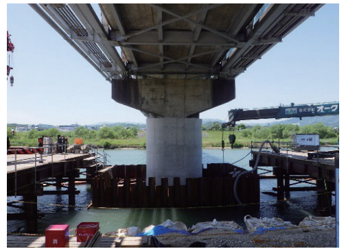
豊岡市 県道 楽々浦玄武洞豊岡線 堀川橋 橋梁耐震補強 (豊岡市)
