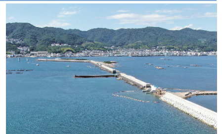
福良港 湾口防波堤(南あわじ市)
