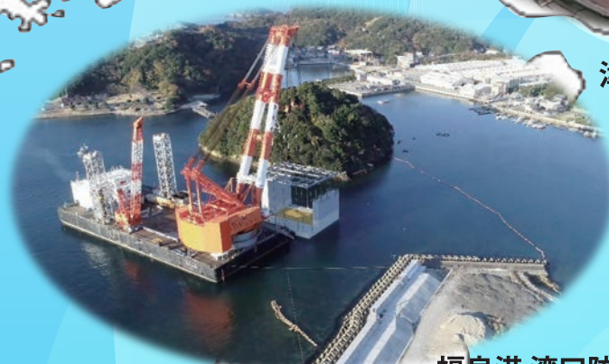
福良港 湾口防波堤整備(南あわじ市)
