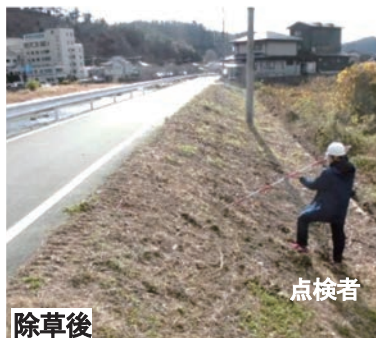
河川堤防の点検前除草 (佐用町)
