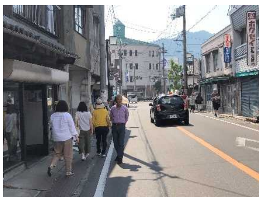
西脇上戸田町線（東本町工区）〔西脇市〕
