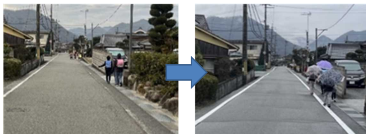
門柳大門線 道路区画線の引直し [西脇市]
