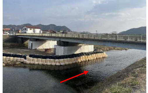
国道427号 日野大橋橋梁耐震補強 [西脇市]
