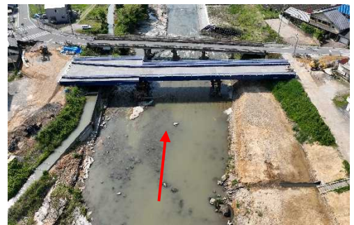
東条川 誉田橋架替 [小野市]
