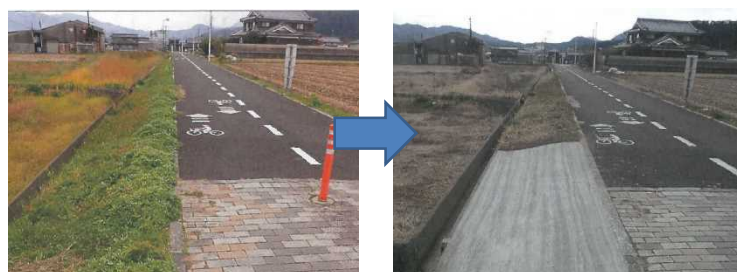
多可柏原線 ぽっぽの道 張りコンクリート施工 [多可町]
