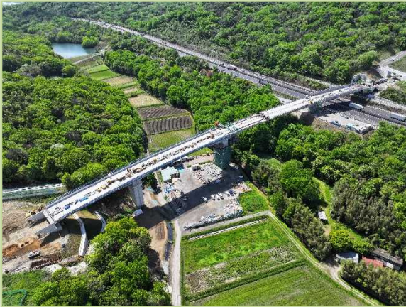
東播磨道(北工区) 跨高速道路(山陽自動車道)橋となる 室山高架橋
