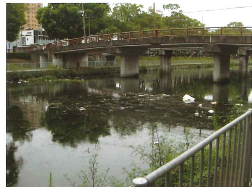
外堀川のゴミ堆積状況
