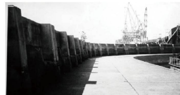
完成当時の防潮堤
