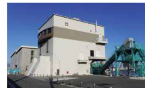
ポンプ場外観
