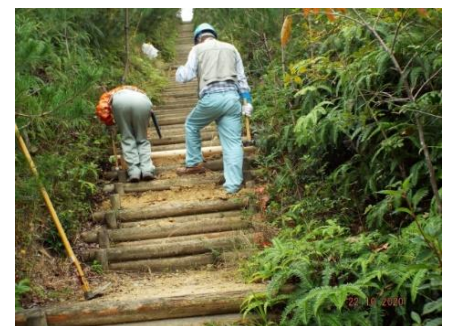
入道山展望台行き階段修理工事
