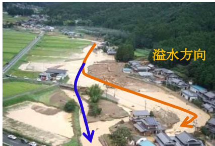
土砂流出による河道埋塞状況 (丹波市市島町徳尾)
