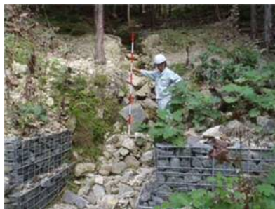
床固工(左)と柵工(右)による土砂等の捕捉状況(多可町八千代区)
