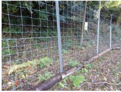
集落防護柵の下部に 間伐材を並べた侵入対策（市川①）
