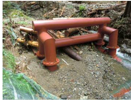
平成 24 年台風 4 号で発生した 流木と土石の捕捉状況（姫路市安富町）
