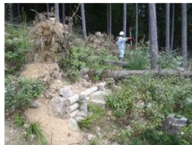
床固工(左)と柵工(右)による土砂等の捕捉状況(多可町八千代区)
