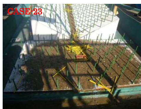
災害緩衝林と簡易流木止め施設による流木・土砂捕捉状況 (流木長 7m、溪岸高 0.45m)
