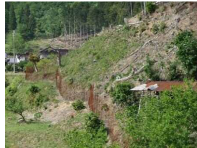
バッファゾーンと集落防護柵の 一体整備（佐用）
