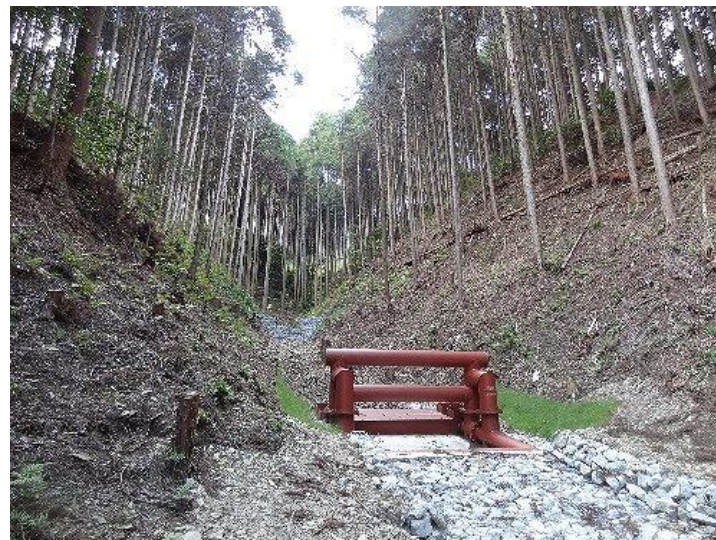
緊急防災林整備（溪流対策） 土砂や流木の流出を防止
