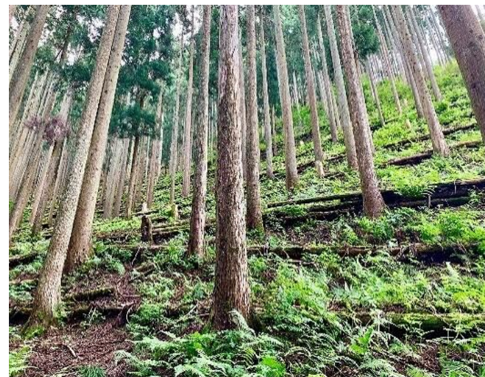
間伐木を利用した土留工（養父市）
