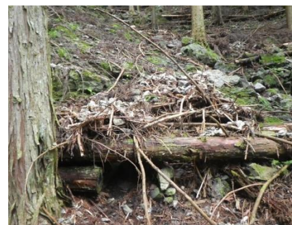
間伐木を利用した土留工（養父市）
