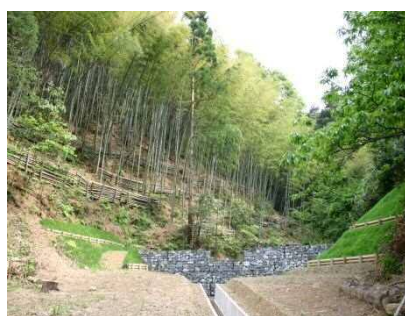
溪流の安定を図る床固工と水路工の設置 (美方郡香美町香住区三谷)
