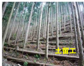
間伐木を利用した土留工を等高線上に設置
