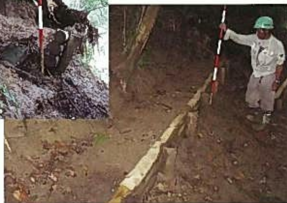
豪雨時に丸太柵工が流出土砂を抑止
