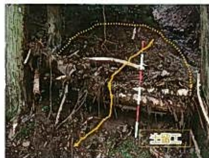
間伐木土留工が流出土砂を抑制
