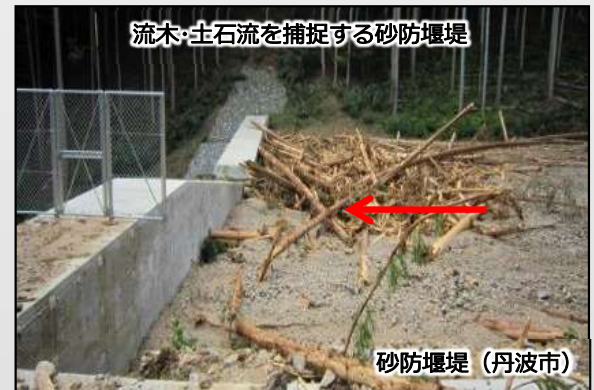
流木・土石流を捕捉する砂防堰堤
