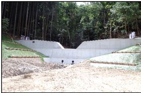
流木・土砂流出防止対策(加西市)
