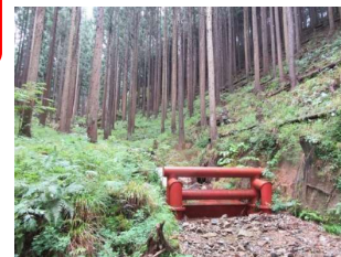
緊急防災林整備（斜面对策）
