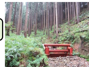
緊急防災林整備（斜面对策）
