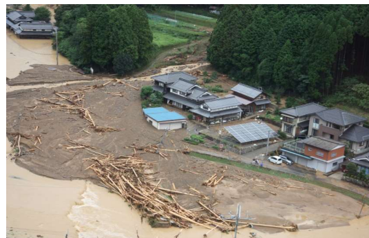
平成26年災害 流木・土砂が下流の集落へ流出（丹波市）
