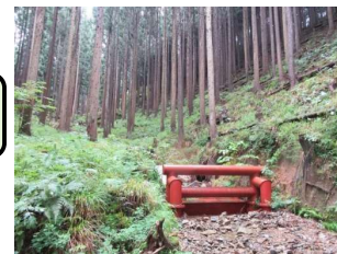
緊急防災林整備（斜面对策）
