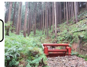
緊急防災林整備（斜面对策）
