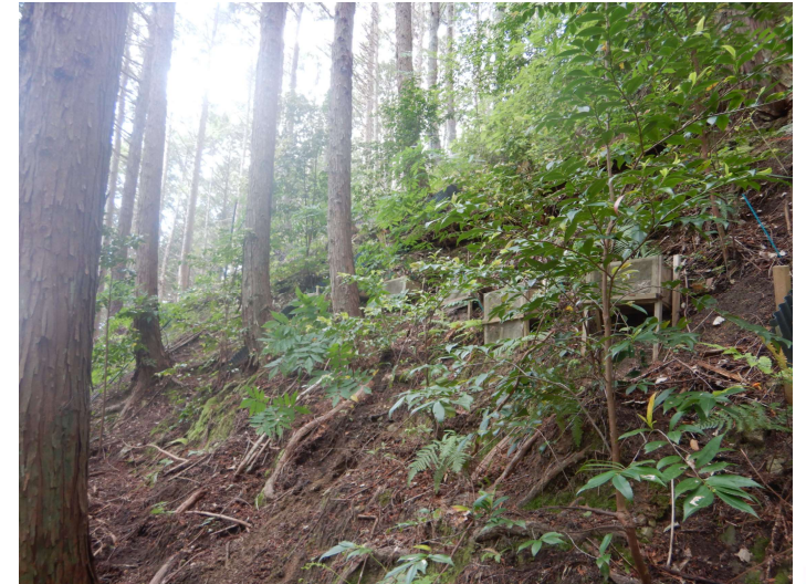
写真 整備区（佐用町口長谷）
