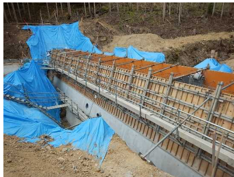
県産木材を使用した型枠用合板の使用状況（宍粟市）
