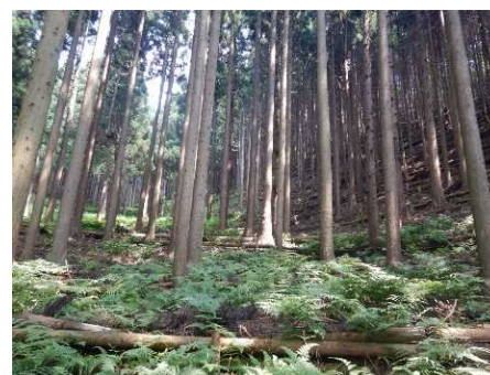
伐倒木を利用した土留工 (朝来市)
