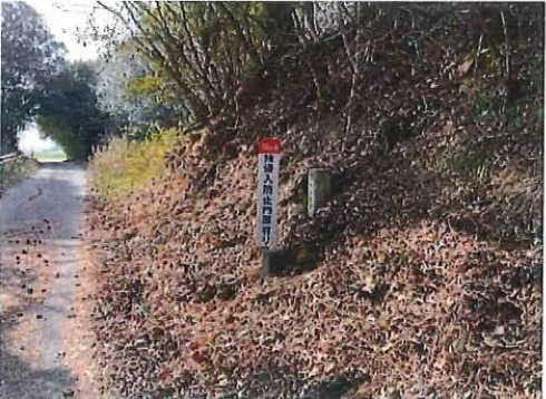
④ 警告看板（淡路市楠本地内）
