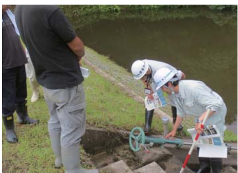
防災パトロールの様子
