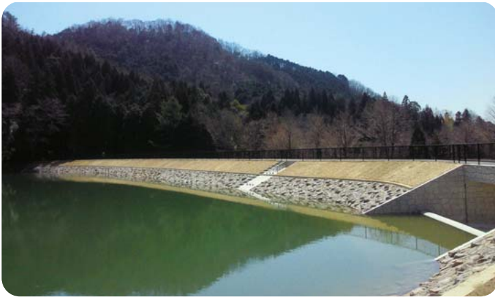
改修工事が完了したため池（篠山市 奥池）
