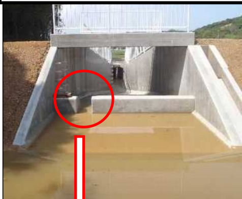
【南あわじ市 洪水吐越流堰の切欠き】
