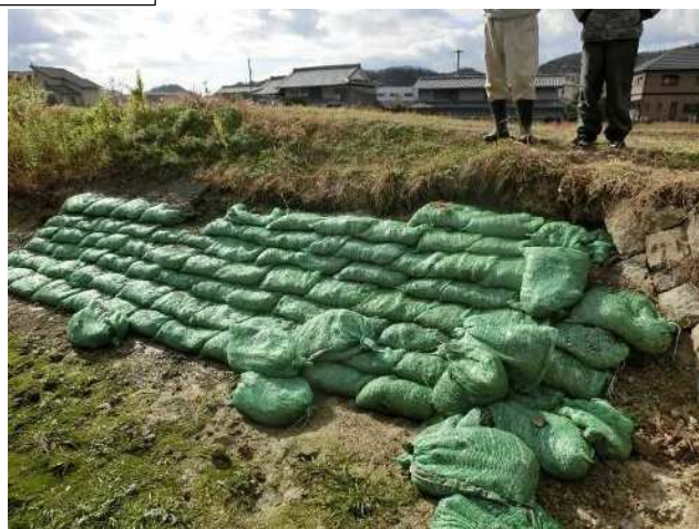
堤体上流法面に土のう設置
