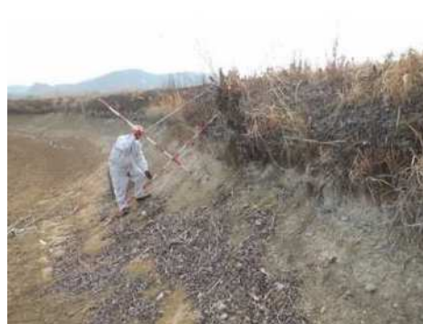
堤体の浸食状況等の点検
