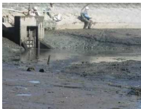
泥土除去後の状況(かいぼり実施後)
