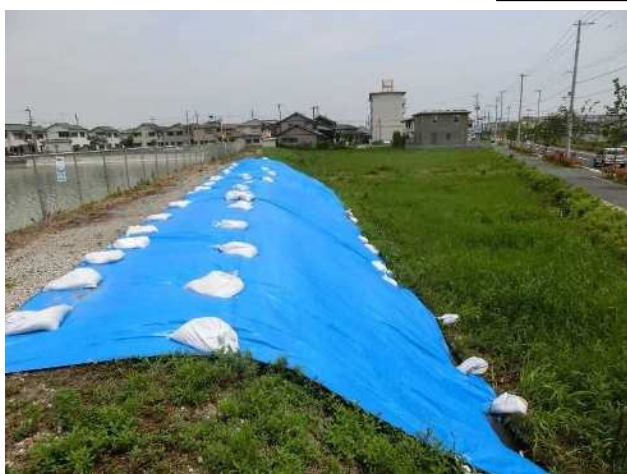
堤体下流法面にブルーシート設置
