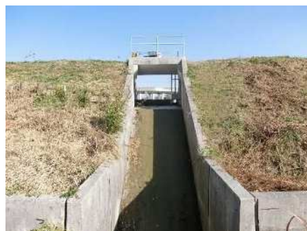
洪水吐(下流側)
