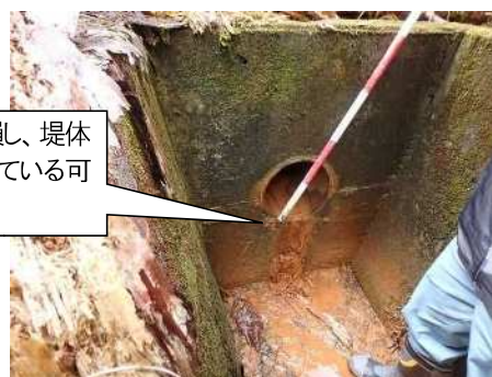
底樋出口(堤体下流)
