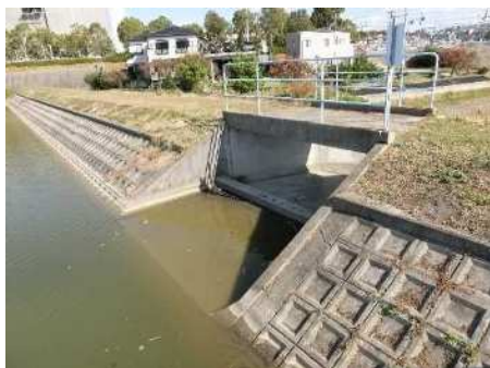
洪水吐(上流側)
