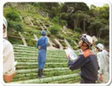
治山施設の点検
