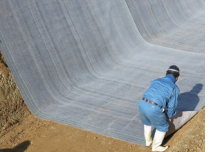
ベントナイトシートの敷設(代替工法の例)
