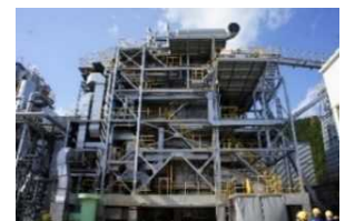
木質バイオマス発電所（朝来市）
