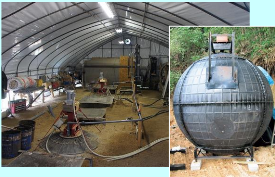
地中に埋められたバイオガスユニット
