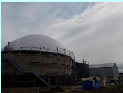
バイオガス発酵槽等の設備（工事中）
