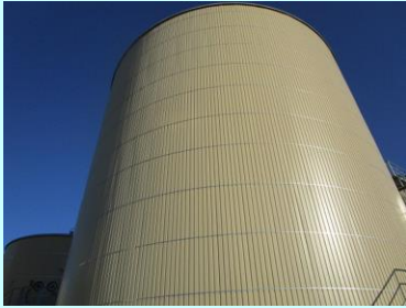
メタン発酵槽
