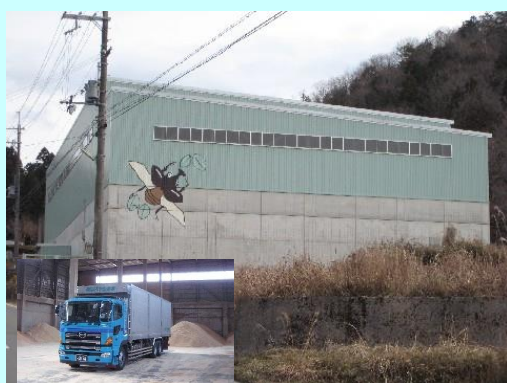
オガ粉保管施設
