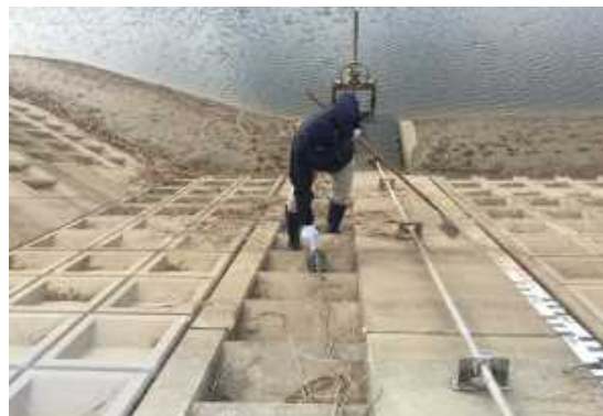
池の点検の様子
