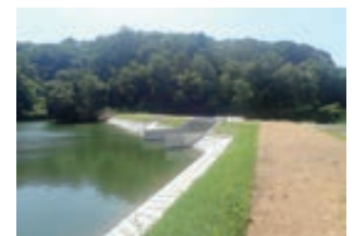
ため池改修状況（三木市渡瀬皿池（わたせざらいけ））
