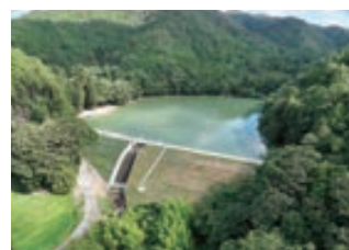
改修工事が完了したため池（丹波篠山市）
