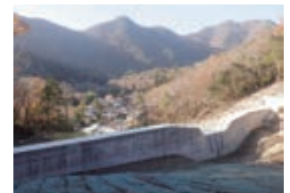
集落を保全する治山ダム（三田市）
