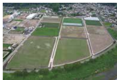
二次整備で大区画化されたほ場 (姫路市)
