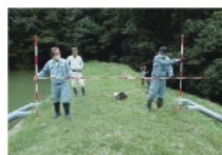
ため池保全サポートセンターによる 巡回点検(三田市)
