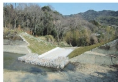
廃止工事が完了したため池 (南あわじ市)
