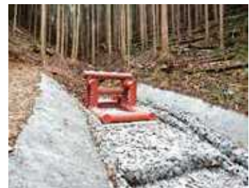
▲危険溪流での土砂・流木対策(姫路市)
