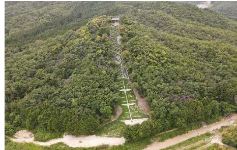
山腹斜面の拡大侵食を防ぐ山腹工
