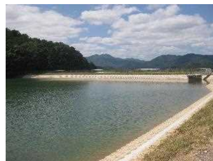
改修したため池
