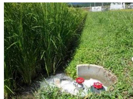
用水路をパイプライン化したほ場
