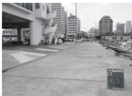
漁港岸壁の耐震化(垂水区)
