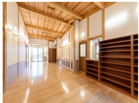
公共施設の内装木質化(西区)
