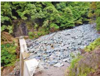
土砂・流木を捕捉し下流への被害を軽減した治山ダム(養父市)
