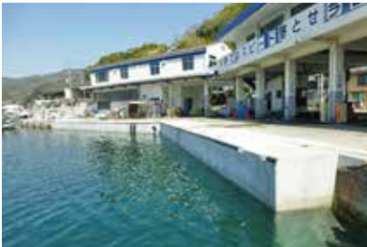
耐震化された物揚場(たつの市)
