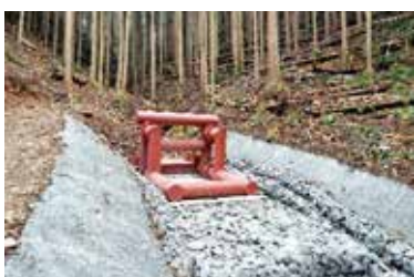
危険渓流での土砂・流木対策(姫路市)
