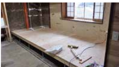
移住希望者による空き家改修(丹波市)
