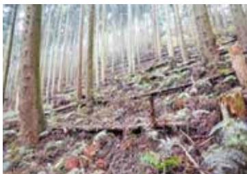
伐倒木を利用した簡易土留工(姫路市)
