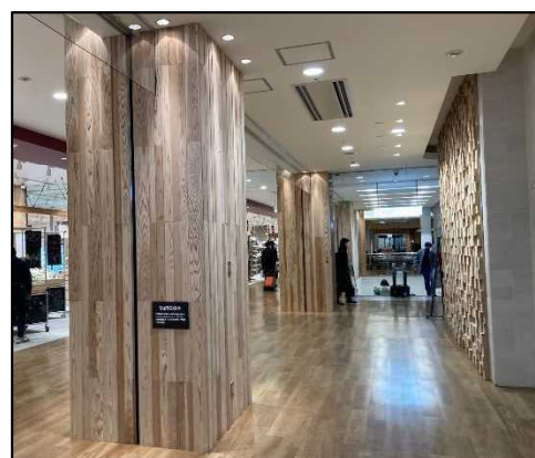
民間商業施設の内装木質化
