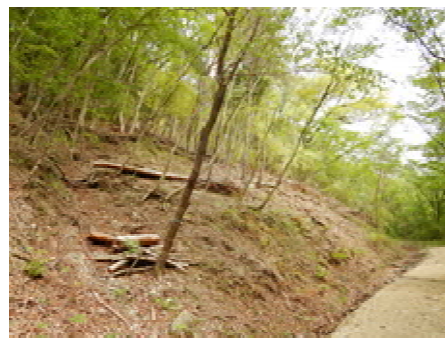
都市山防災林整備(北区)
