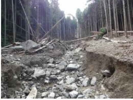
被害状況 (平成26年8月：丹波市)
