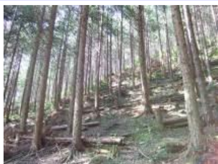
緊急防災林整備(土留工)
