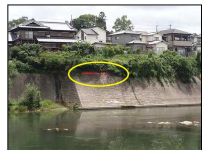
住民の避難の目安となる水位表示板 [加東市]
