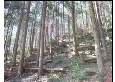
緊急防災林整備(土留工) [丹波市]
