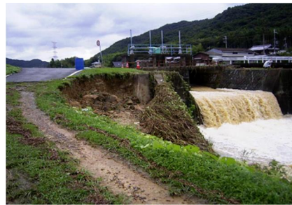
菖蒲池下流の出水状況
