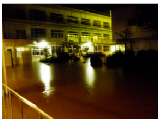
杉原川の氾濫(多可町中町南小学校)
