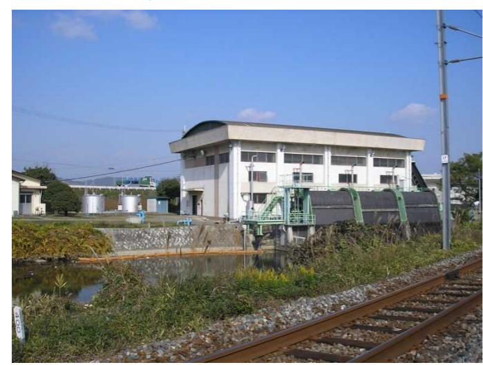
旧排水機場 全景
