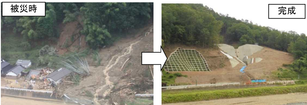
徳尾東谷川[市島町] (砂防えん堤)
