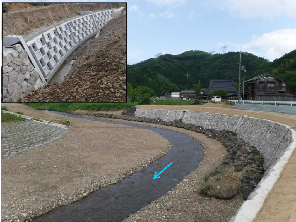
篠山川の河川改修では、生物環境に配慮した環境配慮型ブロック等で整備
