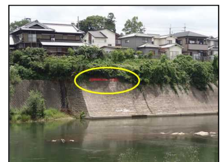
住民の避難の目安となる水位表示板 [加東市]
