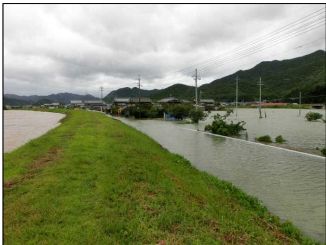
平成25年台風第18号の浸水状況
