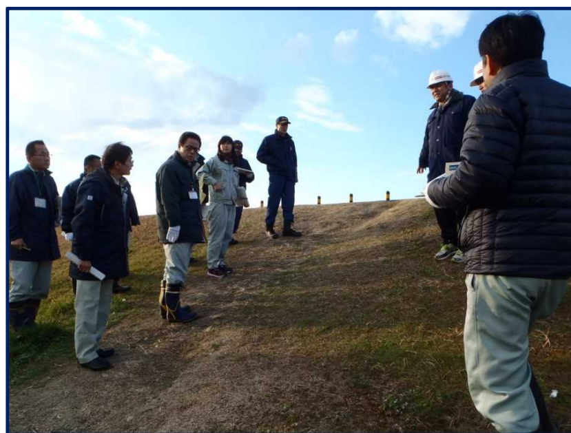
加古川左岸2.4k付近 法崩れ・すべり
