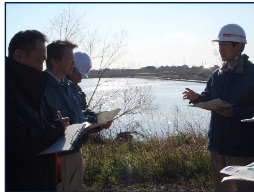
加古川右岸3.8k付近 洗掘
