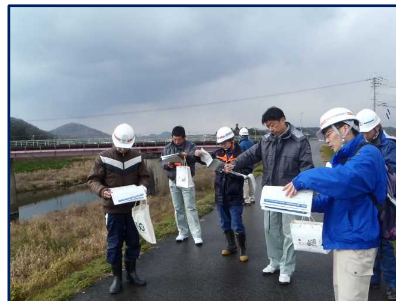
万願寺川左岸0.2k付近 堤防断面不足
