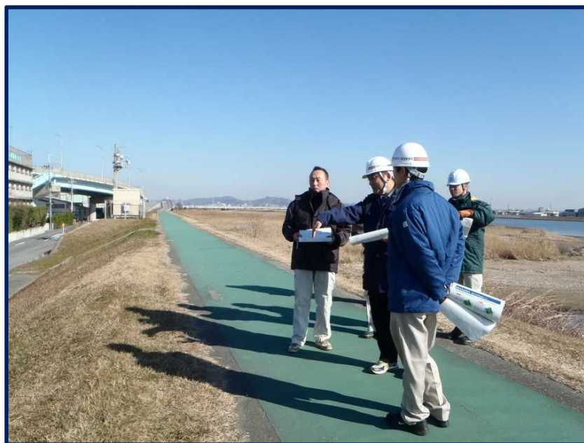
加古川右岸0.6k付近 堤防断面不足
