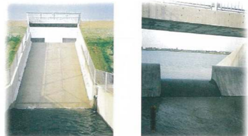
事前放流を行うため、切欠を設置した洪水吐
