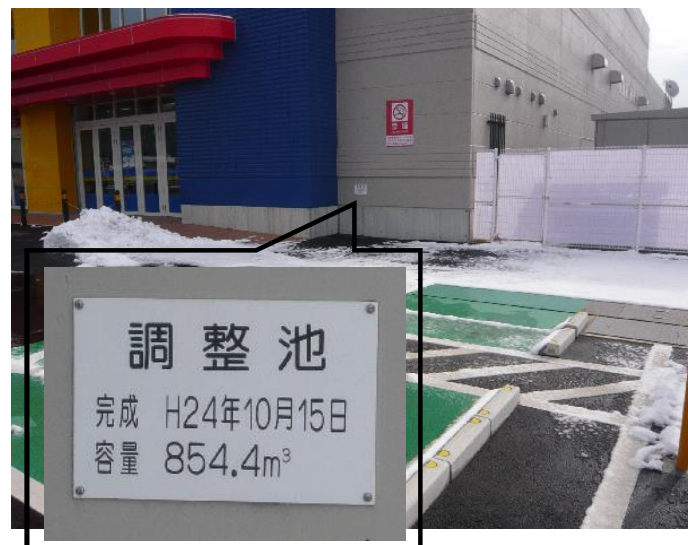
駐車場での地下雨水貯留槽設置
