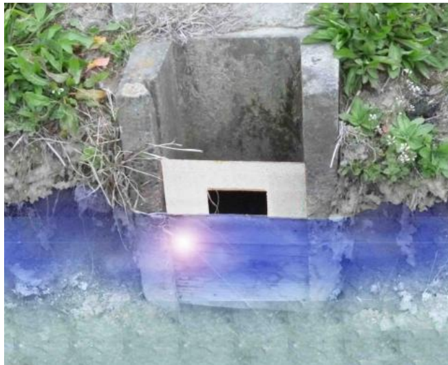
「田んぼダム」の取り組み(堰板設置イメージ)
