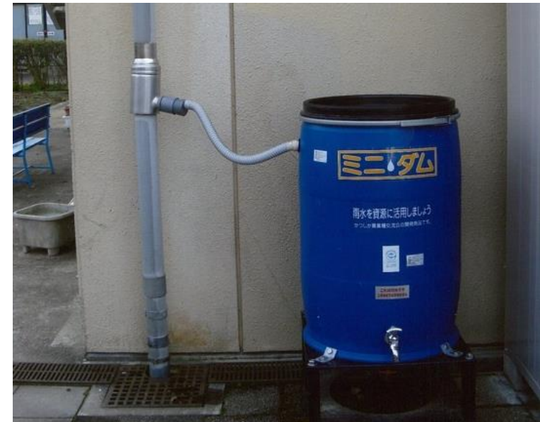
各戸貯留(雨水タンク)
