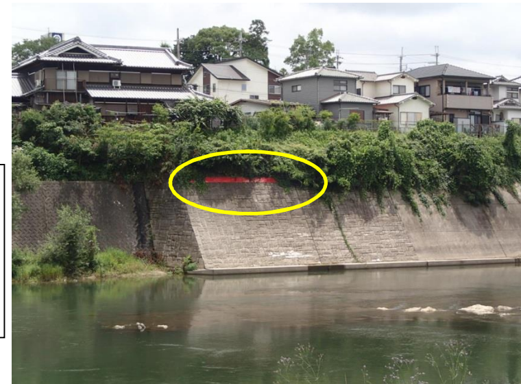
浸水危険水位表示板
