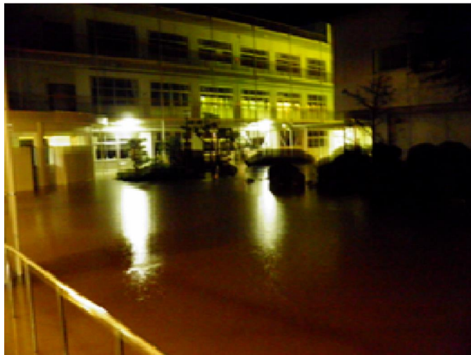
杉原川の氾濫(多可町中町南小学校) (平成23年9月台風12号洪水)
