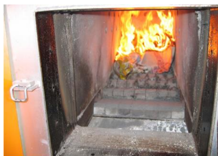
(ボイラー内部)
