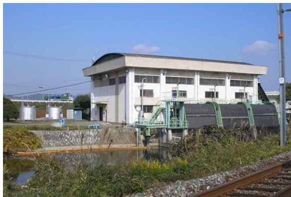
旧排水機場 全景
