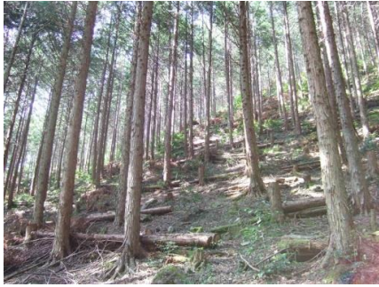
緊急防災林整備（土留工）
