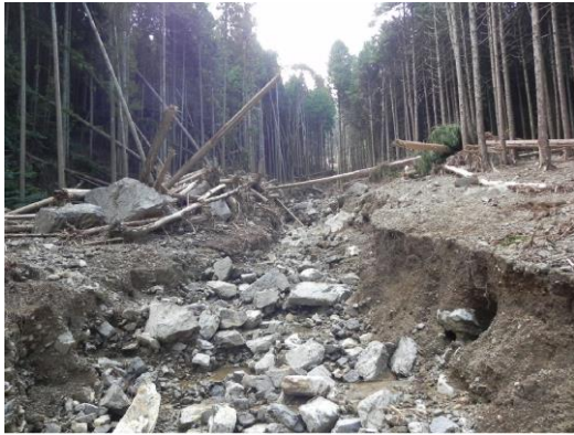
溪流侵食状況 (平成26年8月：丹波市)
