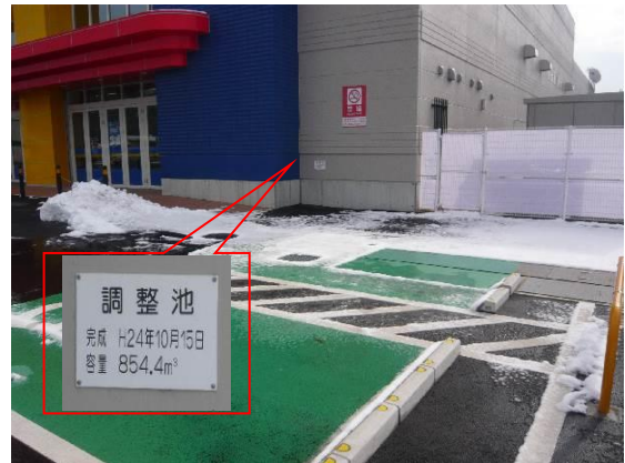
ケーズデンキ氷上店の 地下雨水貯留槽
