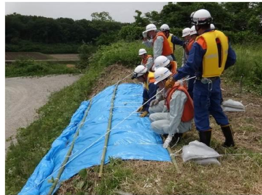
シート張り工法
