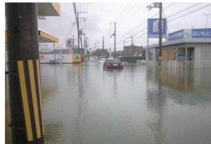
小原宝殿停車場線の出水状況
