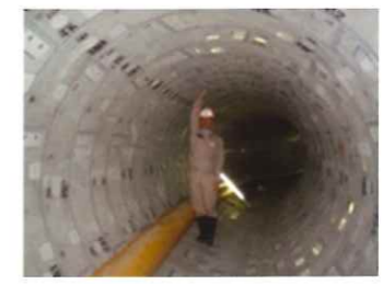
雨水貯留管 (左：西宮市 上：伊丹市)
