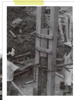
杭打ちの様子 軟弱地盤改良のため木杭を打っているところ
