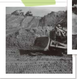
堤体の締固め様子 大型作業機械が効率的に仕事をこなしました
