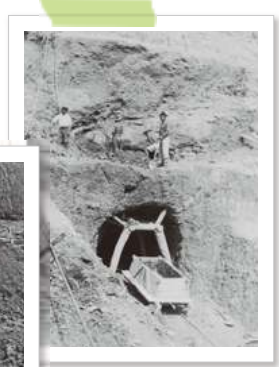
トンネル部土砂搬出の様子 トンネルも木で支えられています。作業は危険と隣り合わせです
