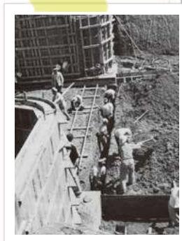
建設中の余水吐の様子 曲線部も丁寧に形づけられています
