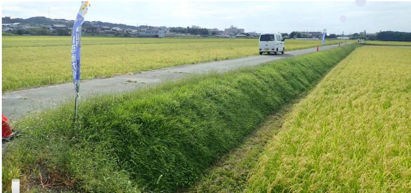
(R5.9.16撮影) R5.8.8に高刈りを実施して以降、真夏に1.5ヶ月間放置した法面状況
