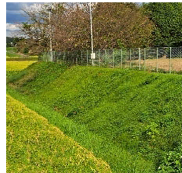
施工から5ヵ月後
