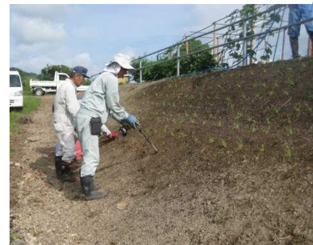
法面が固いため、アースドリルを使用
