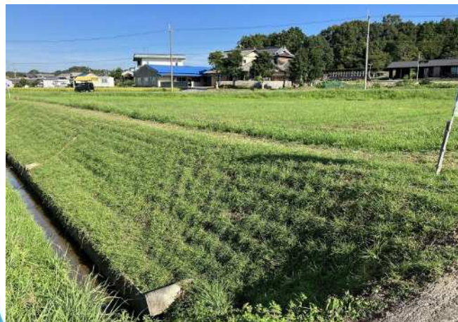
(R5.8.28撮影) ランナーが生長し法面を被覆
