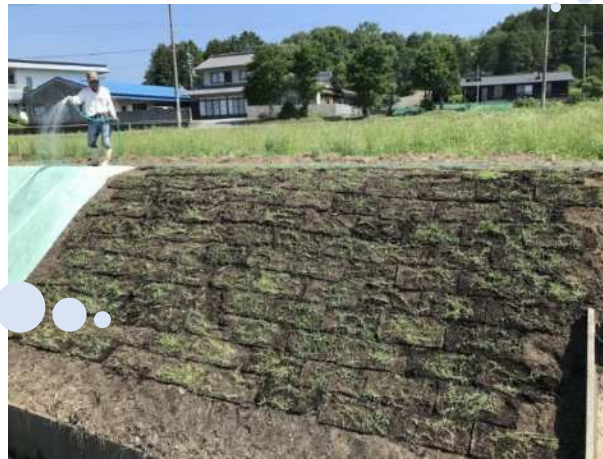
(R5.6.17撮影) 自家製張芝施工（張芝全面張り）
