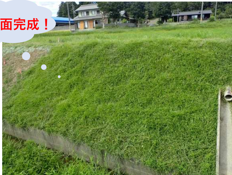
(R5.9.6撮影) 施工から3か月が経過
