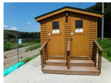
兵庫県で唯一のバイオトイレ
