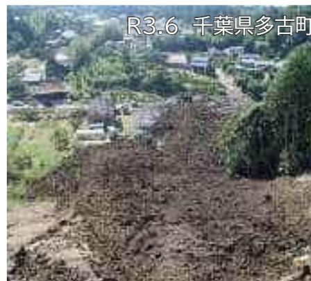
廃棄された土砂の崩落 軽傷者1名、県道通行止め
