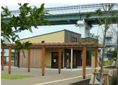
写真-8 パークセンター作業棟
