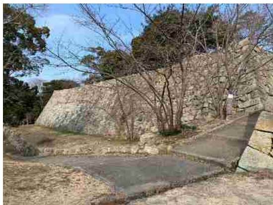
図4-11 ⑧南帯曲輪から稲荷曲輪に登る階段と石垣
