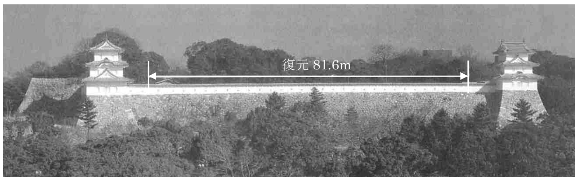
図4-48 巽櫓と坤櫓の間に復元された土塀
