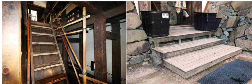
図9-1 松本城のバリアフリー化の事例（右：天守1階階段補助手摺、左：月見櫓出口段差補助） （「文化財の活用のためのバリアフリー化事例集」（文化庁文化財課））
