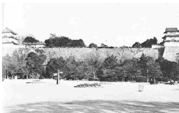
図4-49 昭和57年修復前の巽櫓と坤櫓
